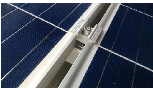
Figura 13 - Aplicação do Grampo Intermediário
