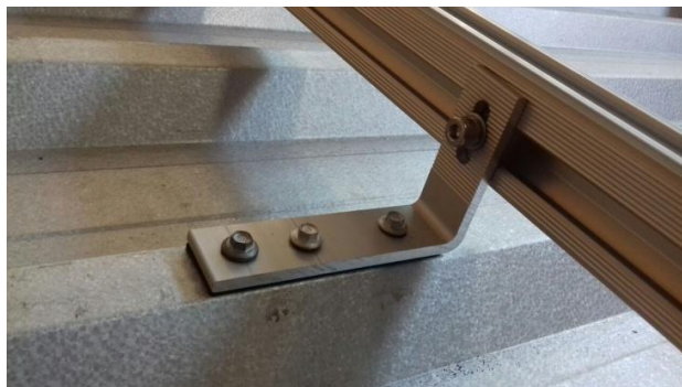
Figura 7 - Aplicação do suporte para telha metálica
